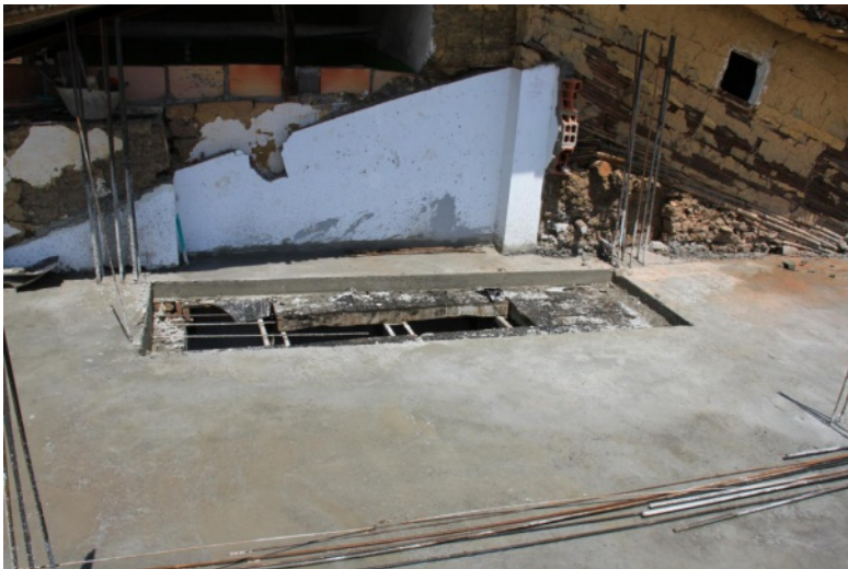
Bild 8 von 10 von Leistungsstand Fototitel: Leistungsstand Foto 8 Datum: Donnerstag, 24.09.2020 Firma: Schütt & Schal GmbH Treppenöffnung
