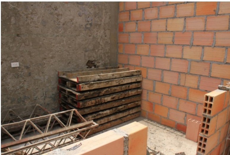
Bild 7 von 10 von Leistungsstand Fototitel: Leistungsstand Foto 7 Datum: Donnerstag, 24.09.2020 Firma: Wackelmann KG Schalung, gelagert
