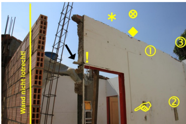
Bild 3 von 10 von Leistungsstand Fototitel: Leistungsstand Foto 3 Datum: Donnerstag, 24.09.2020 Firma: Stein und Bein GmbH Wand Kinderzimmer nicht im Lot
