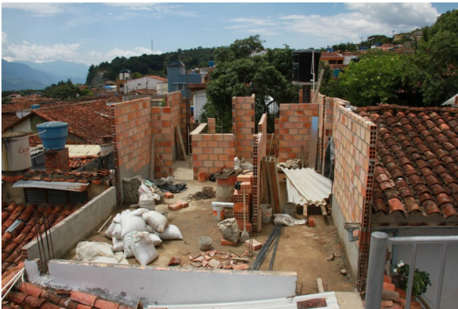
Bild 1 von 2 von Wichtige Baumaßnahmen Fototitel: Baumaßnahmen Foto 1 Datum: Montag, 24.08.2020 Firma: Stein und Bein GmbH Mauerwerksarbeiten
