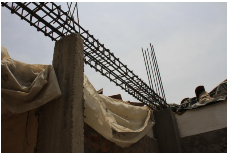
Bild 5 von 10 von Leistungsstand Fototitel: Leistungsstand Foto 5 Datum: Donnerstag, 24.09.2020 Firma: Schütt & Schal GmbH Unterzug über EG
