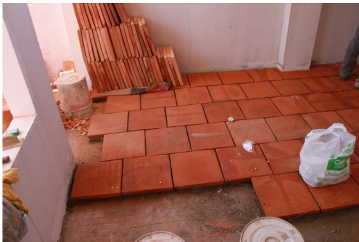
Bild 2 von 3 von Mängel Fliesen nicht plan verlegt, Toleranzen überschritten Fototitel: Mängel Foto 2 Datum: Donnerstag, 24.09.2020 Firma: Kachelmeier GbR
